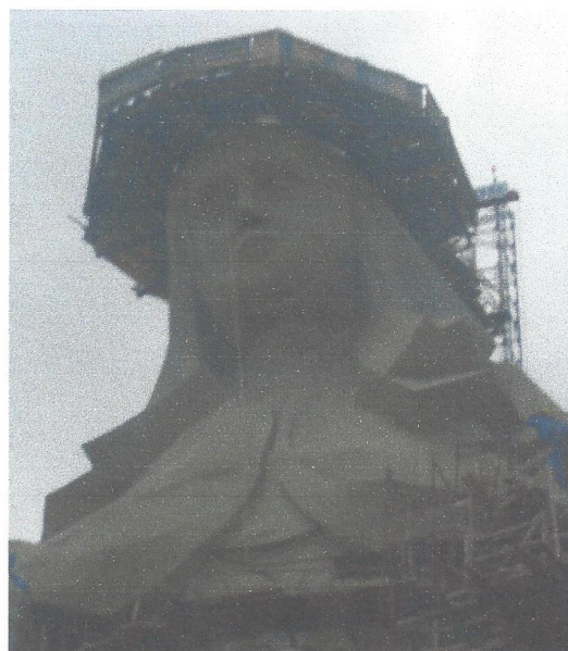
Com mais de duas mil toneladas, a edificação erguida no cume do morro, é fustigada por ventos fortes e elevadas intempéries
